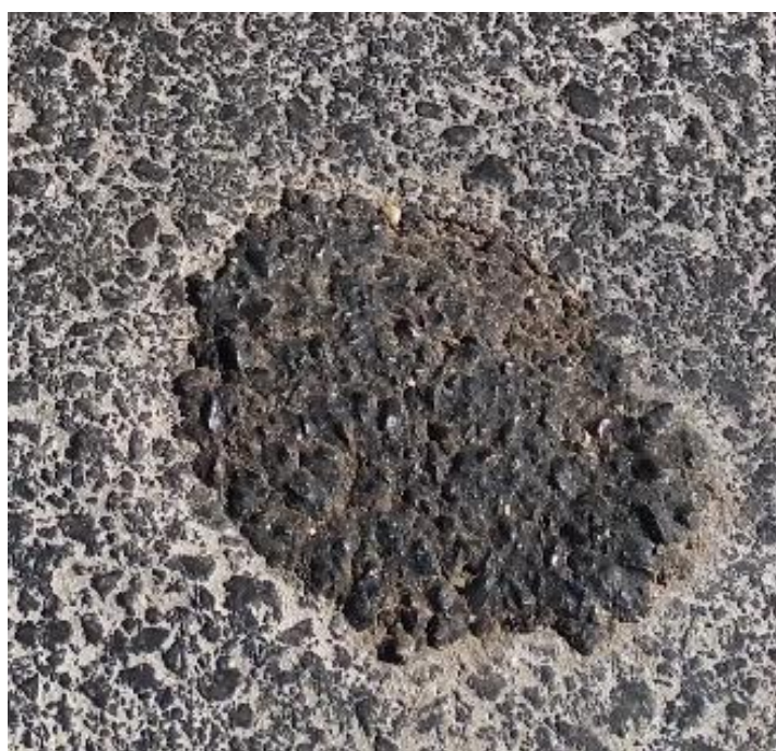
Przykład 5: Nieprawidłowo zabezpieczone miejsce pobrania rdzenia, nadmiar masy wypełniającej
