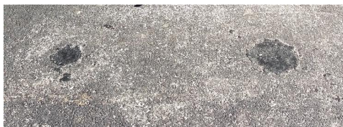
Przykład 6: Nieprawidłowo zabezpieczone miejsce pobrania rdzenia
