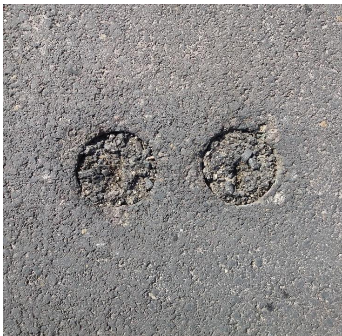
Przykład 7: Nieprawidłowo zabezpieczone miejsce pobrania rdzenia, niedostateczna ilość masy wypełniającej
