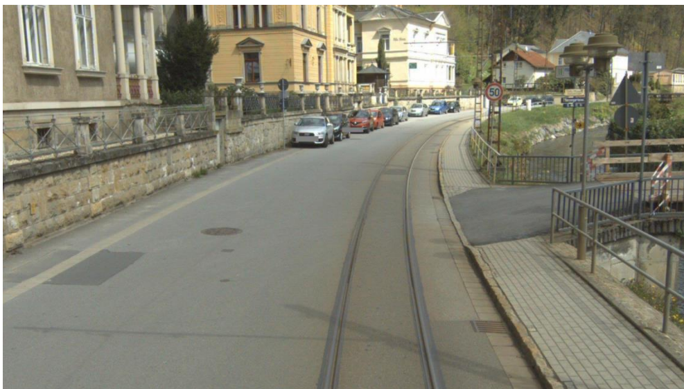
Przykład 8: Torowisko w jezdni
